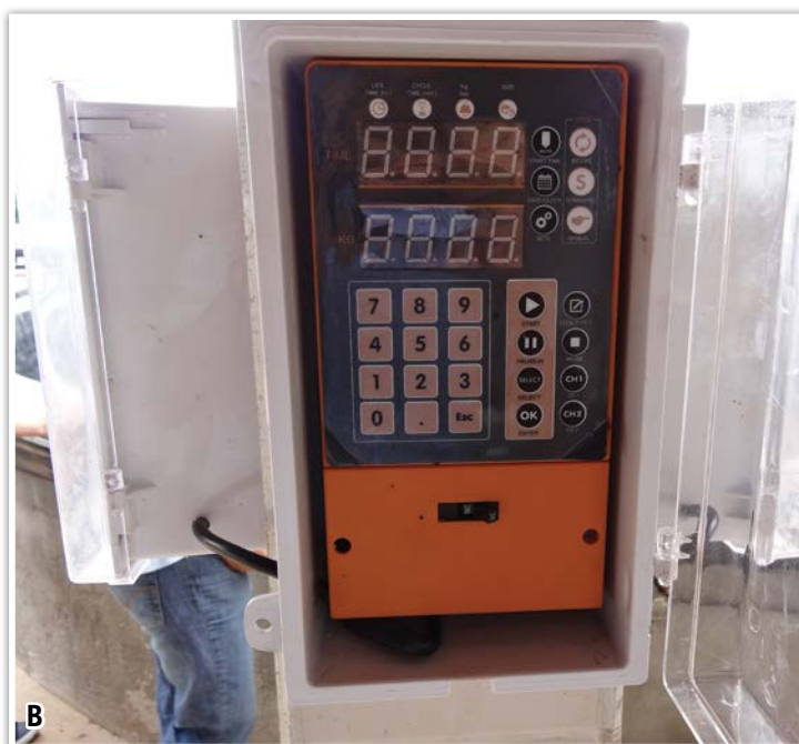
Figuras 9. A , Temporizador com quadro de comando ao lado de um viveiro de camarão. B , no temporizador pode ser programado os dias, a frequências e os horários de funcionamento dos alimentadores automáticos
