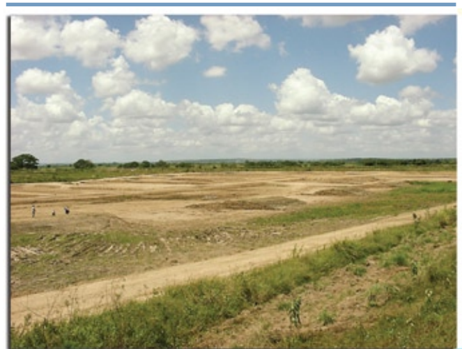
Foto 2 – Área limpa e início dos trabalhos de terraplanagem para a construção de viveiros.
