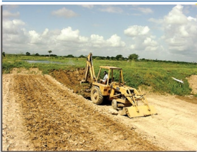
Foto 7 – Retroescavadeira sendo usada para reparo dos taludes de um viveiro.
