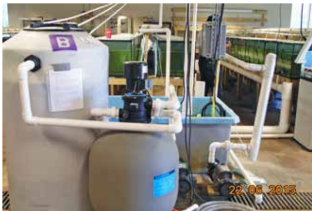
Filtro biológico (biofiltro) com substratos plásticos em movimento (cilindro mais alto) ao lado de um filtro mecânico de esferas plásticas em um laboratório de nutrição de peixes da Universidade de Auburn, Alabama, USA
