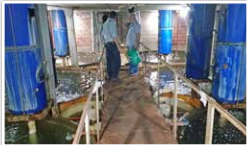
Sistema de recirculação de médio porte para a engorda de tilápia em tanques circulares de concreto, cada um equipado com um filtro biológico por escoamento (dois tambores azuis empilhados)
